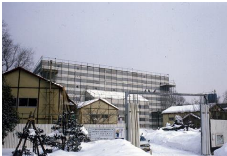
昭和 59 年の修復工事中の様子（札幌市公文書館 所蔵）
